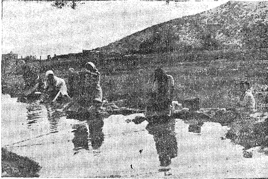
El agua de los tajos era aprovechada para la limpieza de la ropa, utilizándose lavaderos improvisados y sumamente incómodos.
